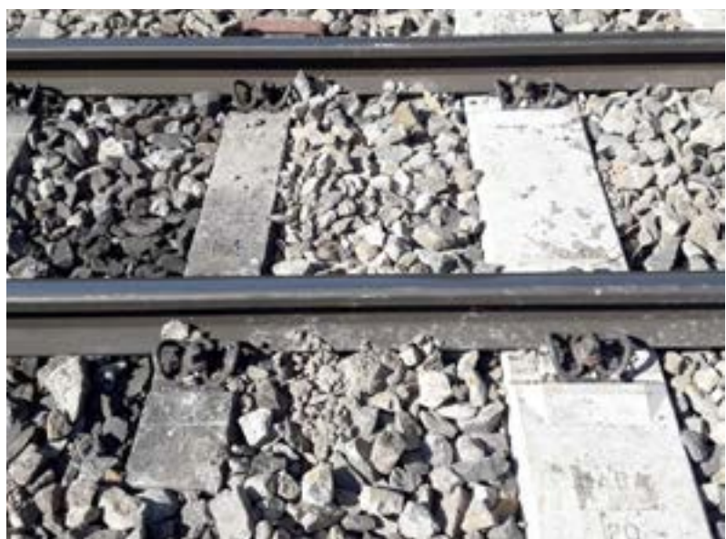
Im Vergleich zu den alten Bahnschwellen sind die neuen größer und schwerer. Die neuartigen Schwellen halten den steigenden Anforderungen an die Strecke stand und werden in Zukunft auf der gesamten Strecke verbaut.
